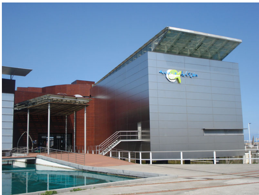
Fachada y acceso principal
